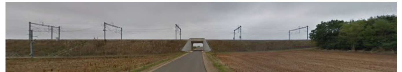
Vue sur la LGV SEA depuis la RD61 (source : street view)
