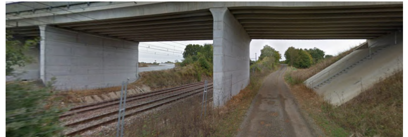
Vue sur la ligne Paris-Poitiers-Angoulême-Bordeaux sous le pont sur la RD61 (source : street view)
