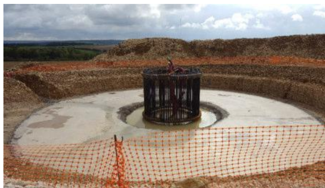
Béton de propreté, bride d'ancrage et fourreaux de réservation pour les câbles
