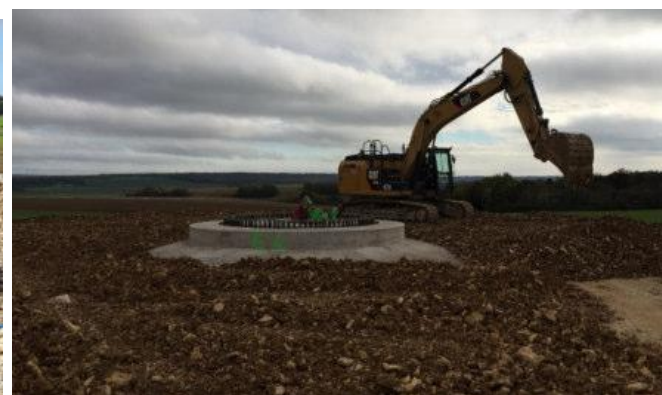
Exemple de fondation en surface
